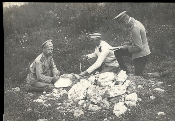
Проведение подрывных работ. Установка мины
